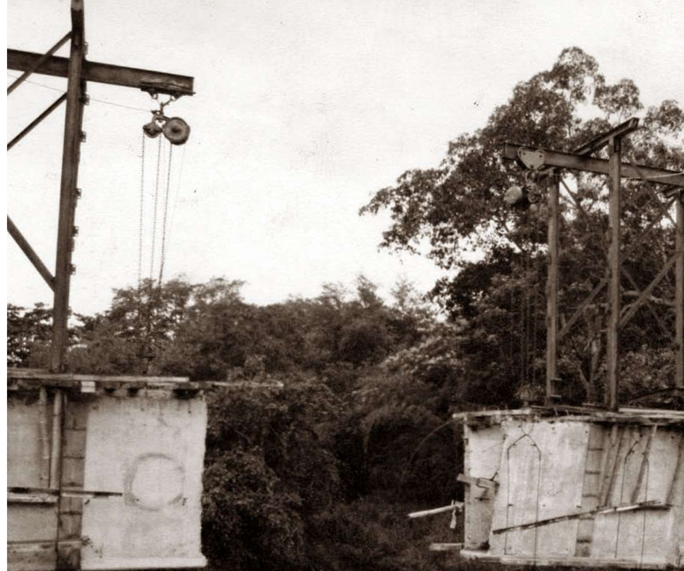
Puente “El Paso”, 17-ene-1986, alistando el cierre de la brecha mediante la unión de las dos dovelas, para sellarlas (Gantiva A., comunicación personal, 2023). Kilómetro 114, vía Bogotá -Girardot.
