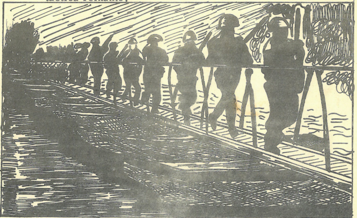
Fig.No. 16 TROPAS EFECTUANDO EL PASO POR LA PASARELA DE ALUMINIO
