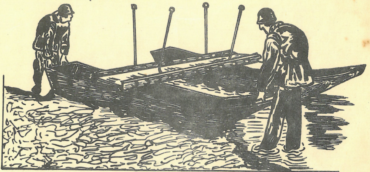
Fig. No. 11 TRAMO FORMA DE H LANZADO
