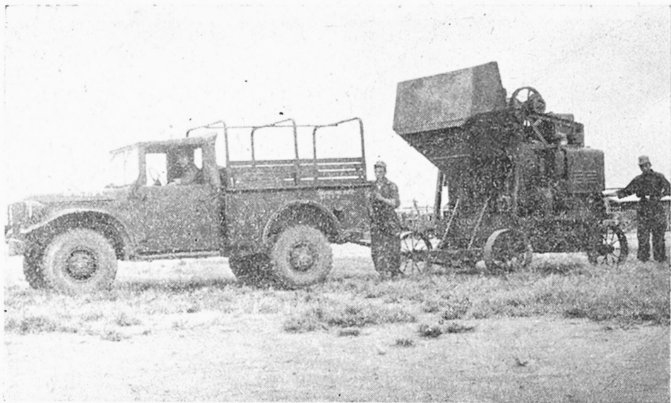
Figura 11 — Mezcladora de concreto de 16 pies cúbicos transportada por camión de carga de 3/4 de tonelada.
